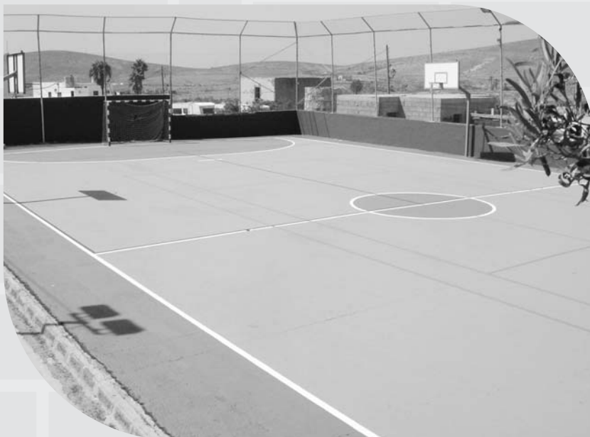
Pista Polideportiva de Tuineje, terminada.
