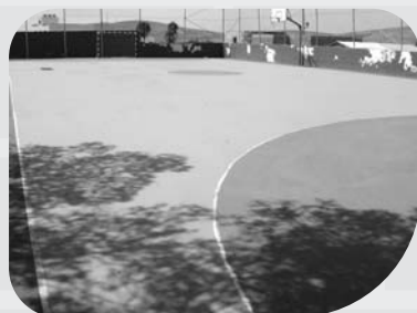
Pista Polideportiva de Tuineje, en obras.
